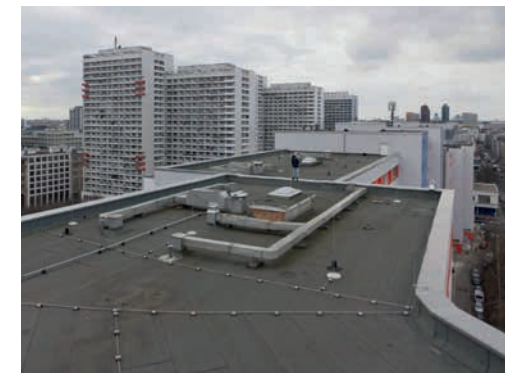
Dachfläche eines Plattenbaus an der Leipziger Straße in Berlin © Stadtgewitter e.V.
