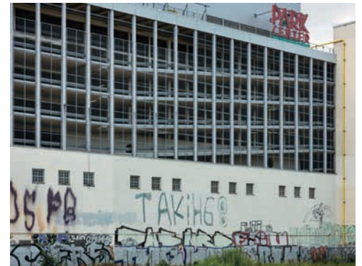
Leerstehendes Parkhaus des Park Center Treptow, Berlin © Andreas Gehrke
